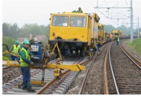
Longs Rails soudés sur traverses béton
